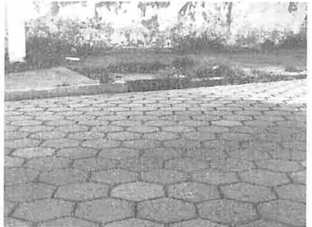
Foto 6 – Boca de lobo para captação e Drenagem da Av. Oceano Índico.
