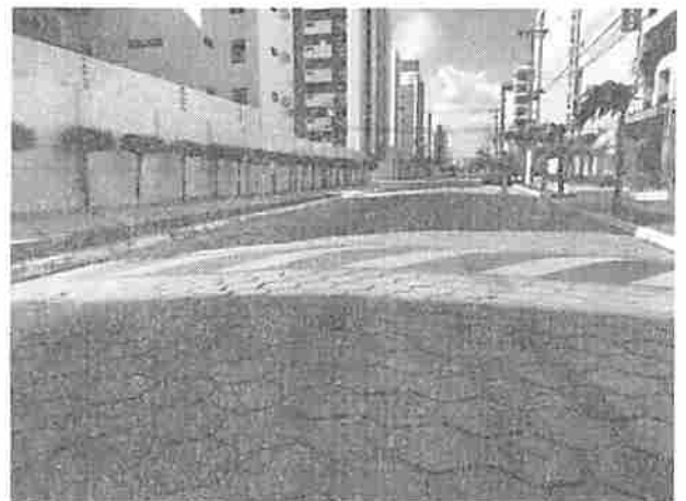
Foto 8 – Lombadas existente em material asfáltico.
